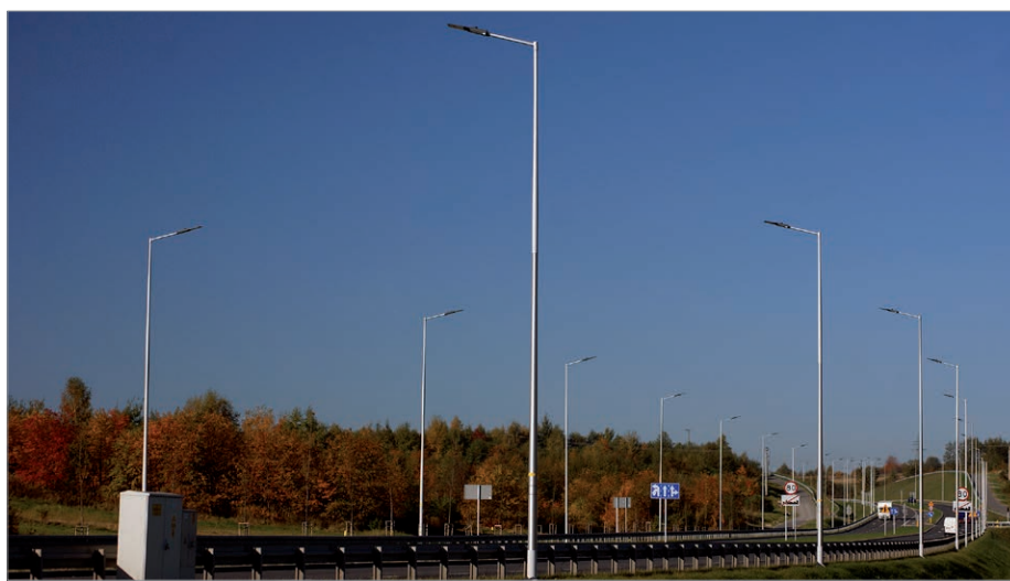
Elektromontaż Rzeszów był pierwszym polskim przedsiębiorstwem, które wprowadziło do produkcji lekkie słupy z blachy stalowej, dodatkowo zabezpieczone antykorozyjnie cynkowaniem zanurzeniowym
